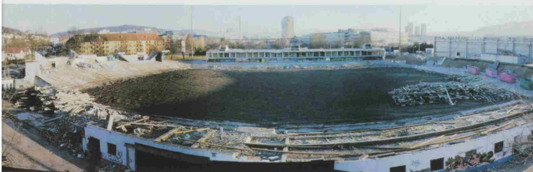
26. Dezember 2008 – Abbruch des Hardturmstadions (Blick Richtung Stadt).
